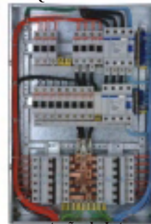
Sistema com proteção de Interruptores DR de alta e baixa sensibilidade.
