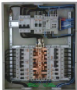
Sistema de Distribuição com controle de iluminação.
